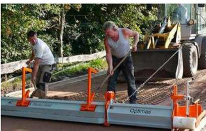
A Régua para Sarrafear o Solo (Maxi Screed Optimas), é a ferramenta ideal para preparar a superfície destinada para a pavimentação. Após o trabalho de terraplanagem o Maxi Screed faz o nivelamento adequado do material aplicado para nivelar área a ser pavimentada. O design bem concebido permite a colocação de várias camadas na base (areia, cascalho), fazendo, com isso, a otimização do tempo utilizado na preparação da área desejada.
